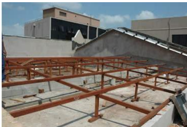
- Detalhe do berço para distribuição das cargas
